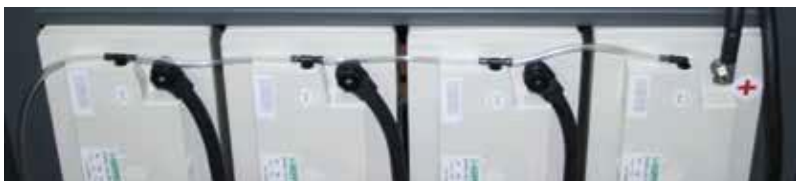
Obrázek 6: Příklad centrálního odplynění
